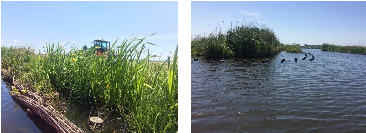
Figuur 6-1 voorbeelden van vaste beschoeiing in de veldwetering in Groot-Wilnis Vinkeveen. Links is de beschoeiing dicht op de kant gezet (1m) en functioneert goed om de oever te beschermen tegen golfslag en stroming, rechts is de beschoeiing ver uit de kant gezet (>3m) in diep water op een erosiegevoelig punt.
