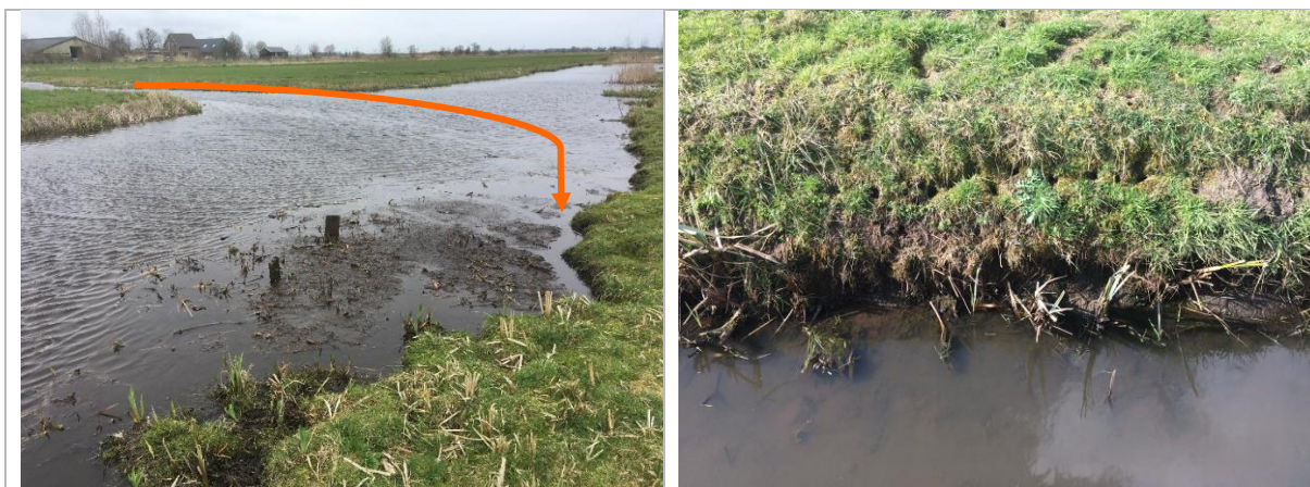
Figuur 3-3 Voorbeelden waar stroming (links) en muizenholen (rechts) de oevers belasten en leiden tot afkalving.
