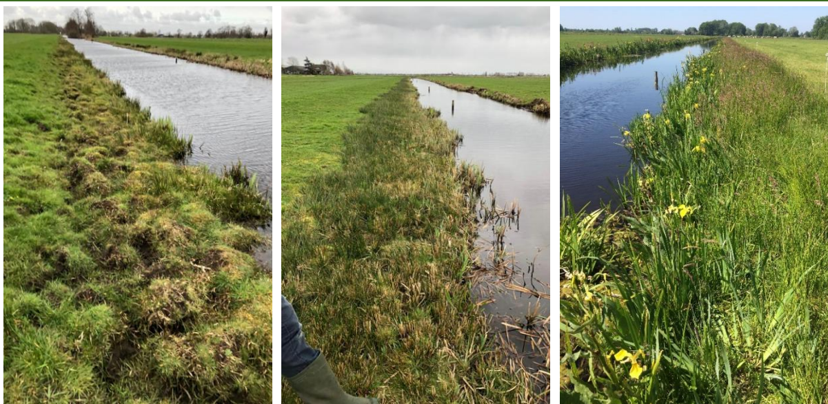
Figuur 6-2 Oever in Groot-Wilnis Vinkeveen waar beweiding plaatsvindt (links) en rechts is de andere oever van hetzelfde perceel waar geen beweiding plaatsvindt omdat een draad is gespannen en waar beschoeiing is geplaatst (palen). De linker twee plaatjes zijn dezelfde slootrand in het vroege voorjaar en eind mei.
